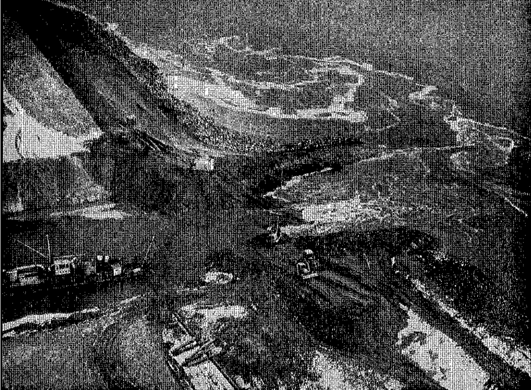
Het openen van de bouwput op 11 maart
