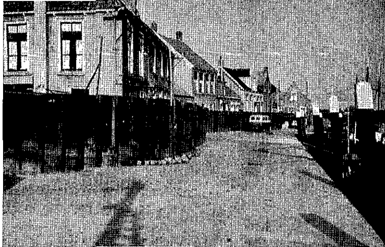
Kistdam ter versterking van de hoogwaterkering in Bruinisse
